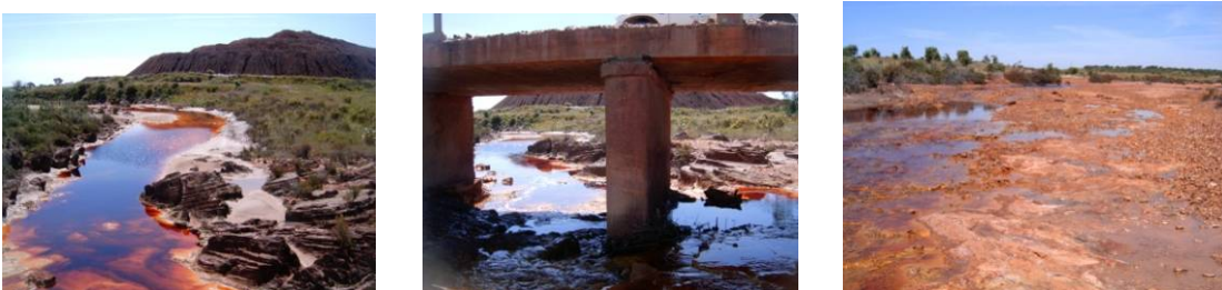
Fotos 5, 6 y 7: Vistas del .cauce del arroyo de la tiesa, a la altura donde se tiene prevista la actuación
